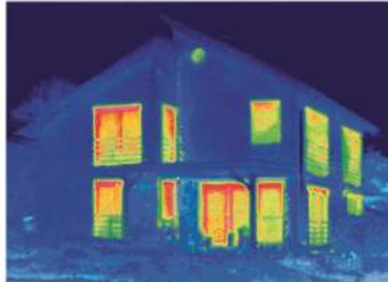
Thermografien zeigen deutlich, wo ein Haus unkontrolliert Energie verliert. Rot bedeutet hierbei den Verlust von Wärme und damit hoher Energie.
